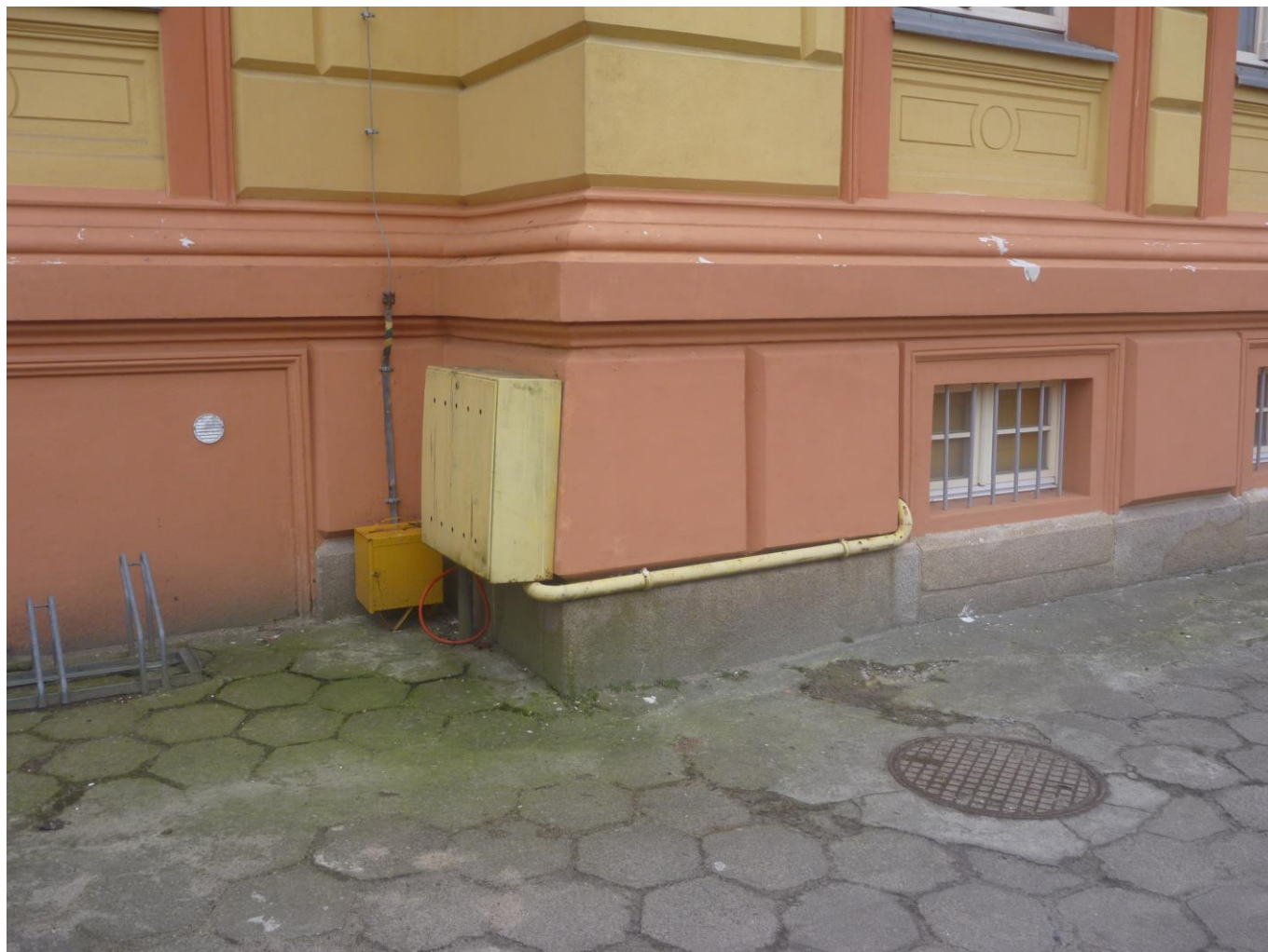
Fot. 17 Droga wewnętrzna – cokół budynku
