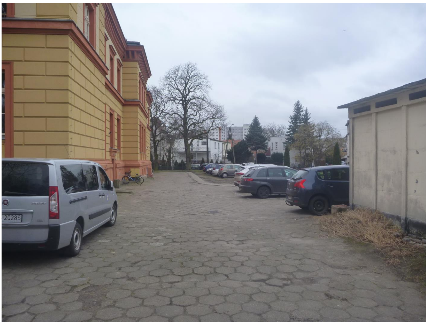
Fot. 24 Droga wewnętrzna – widok od strony wschodniej
