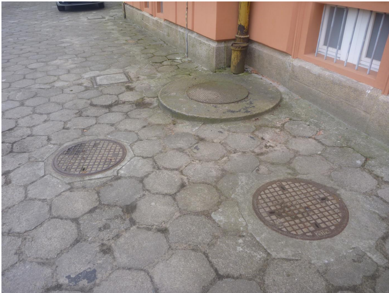
Fot. 21 Droga wewnętrzna - studzienki
