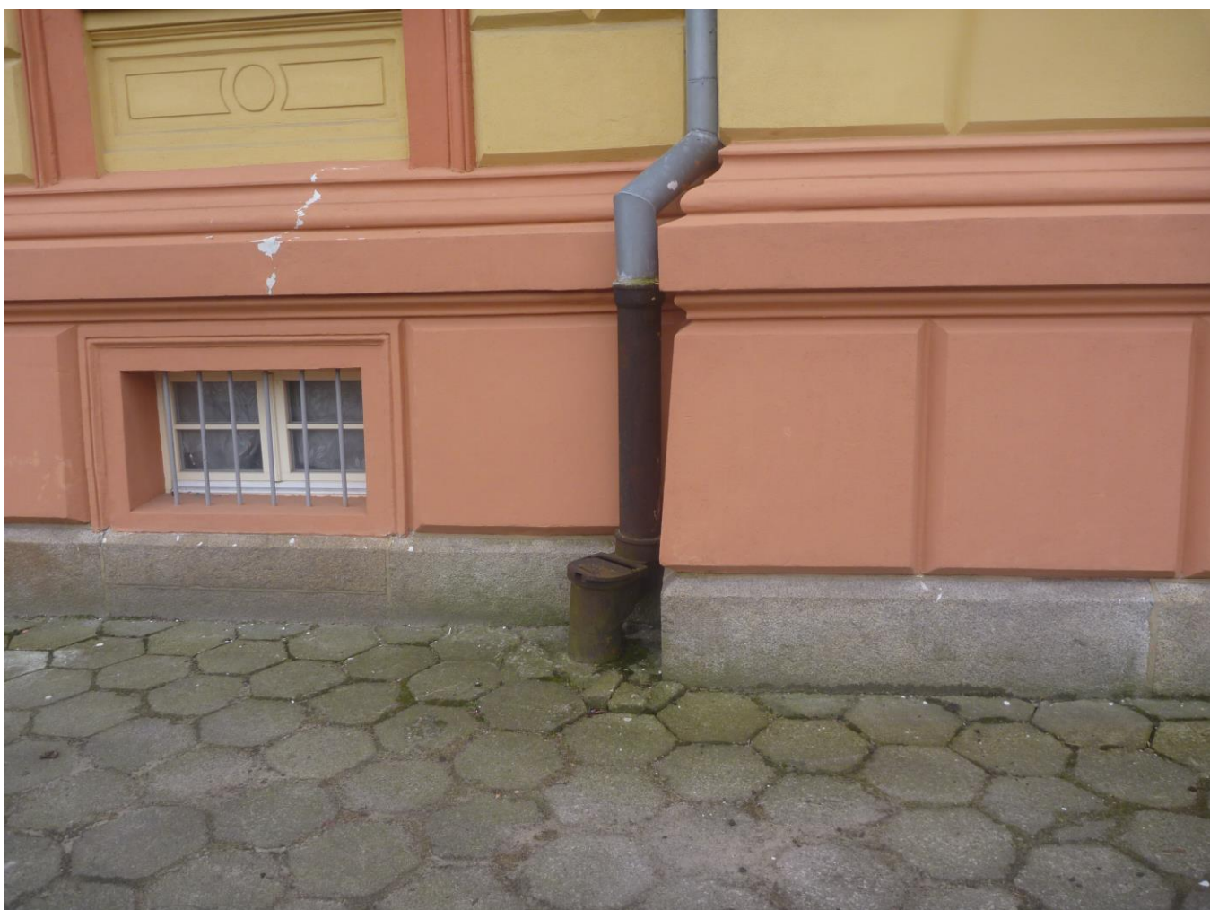
Fot. 22 Droga wewnętrzna – cokół budynku
