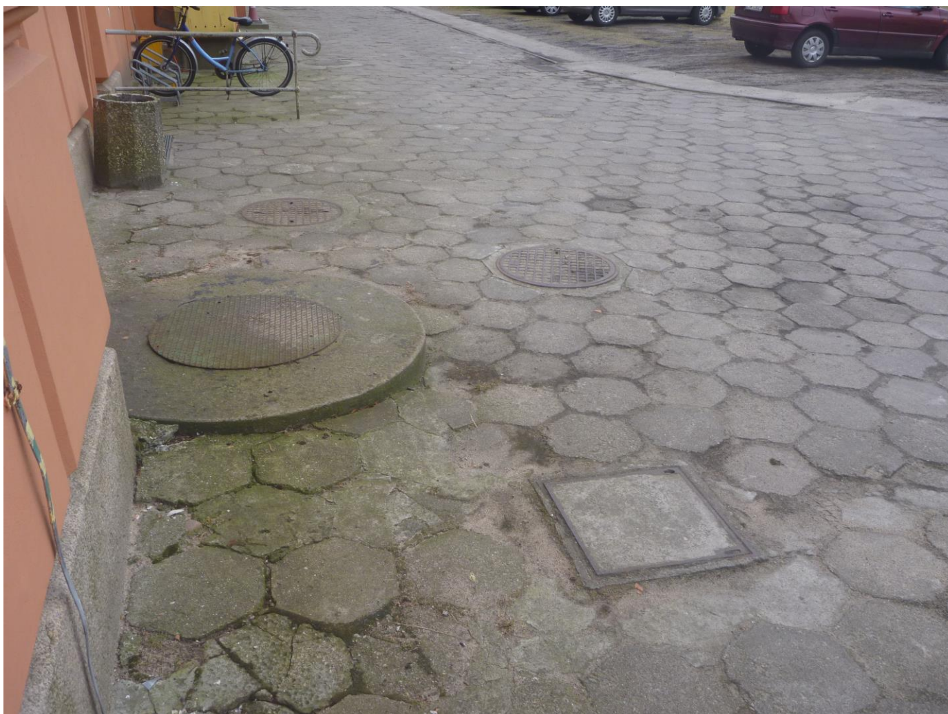
Fot. 20 Droga wewnętrzna - studzienki
