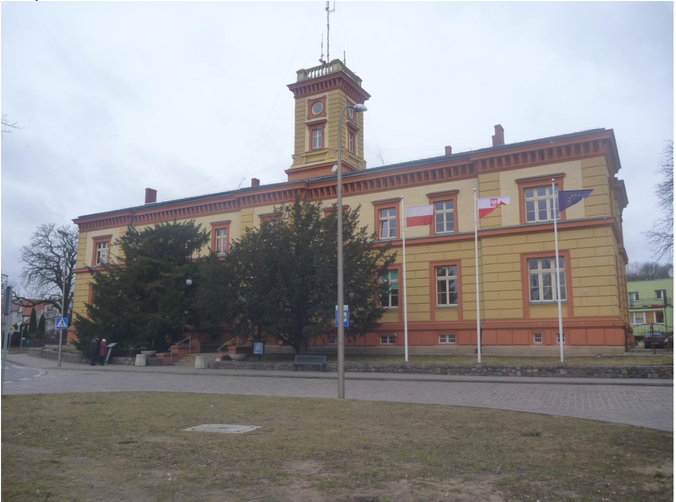
Fot. 01 Widok ogólny – elewacja frontowa
