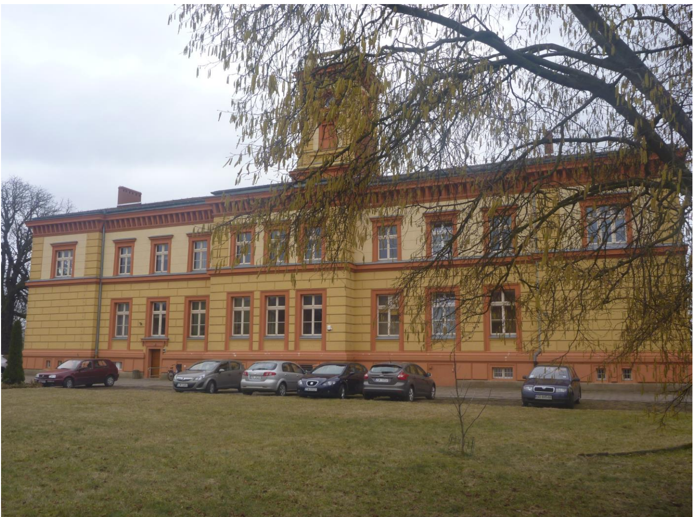
Fot. 02 Widok ogólny – elewacja tylna
