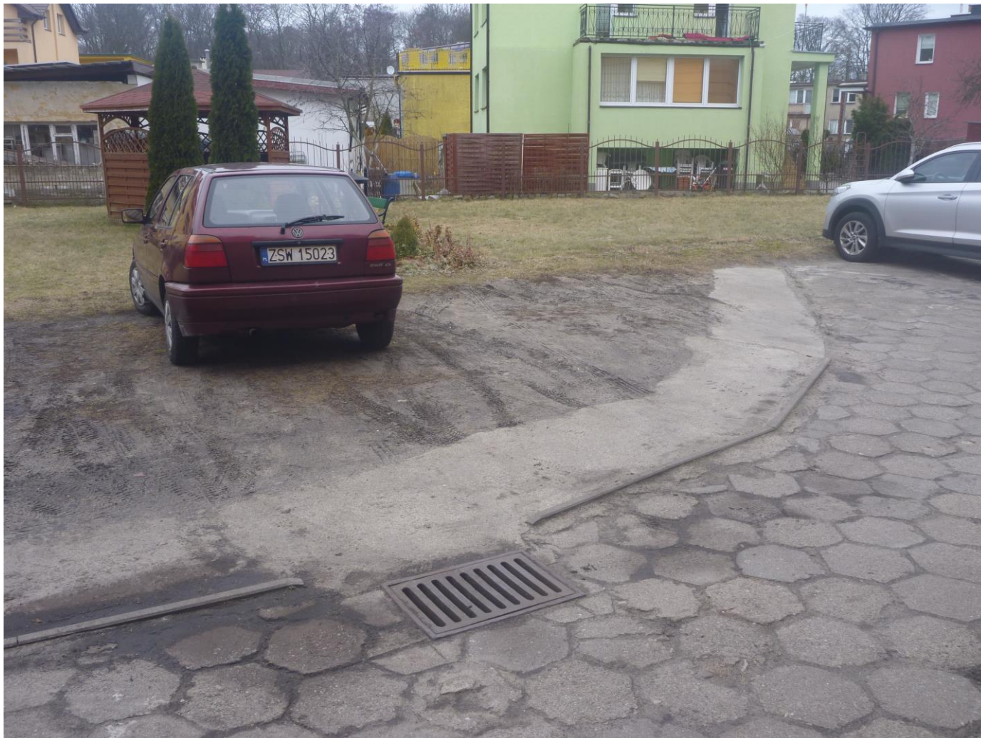
Fot. 19 Droga wewnętrzna – studzienki i istniejące miejsca parkingowe
