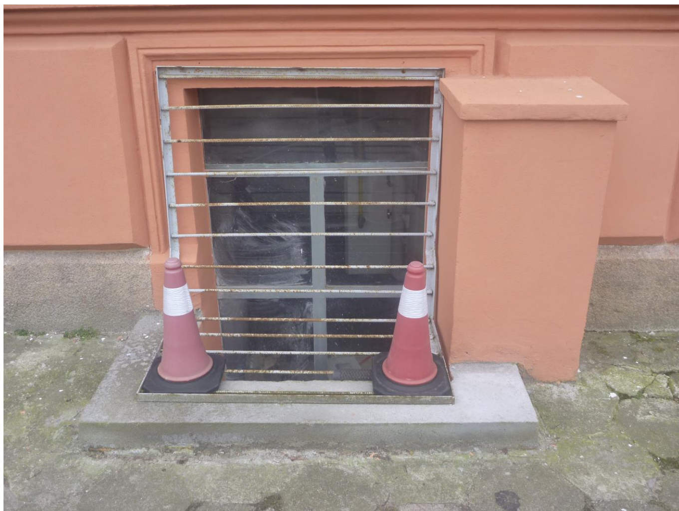
Fot. 18 Droga wewnętrzna – cokół budynku
