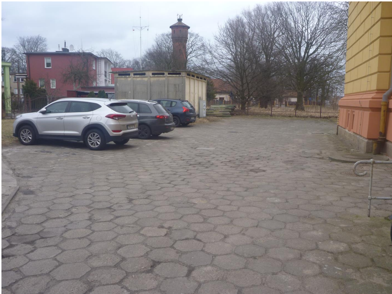
Fot. 23 Droga wewnętrzna i plac manewrowy
