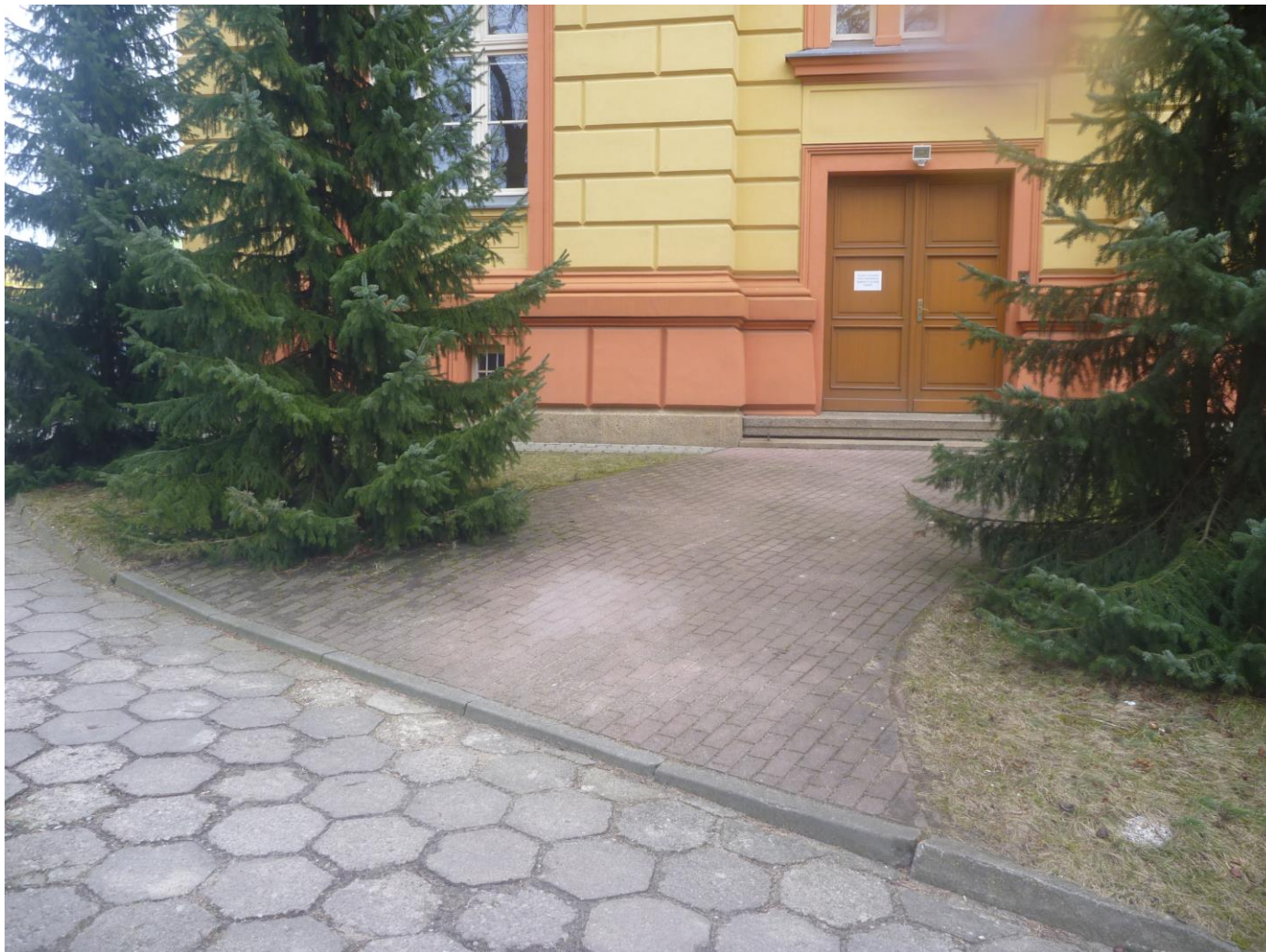
Fot. 07 Chodnik do wejścia bocznego
