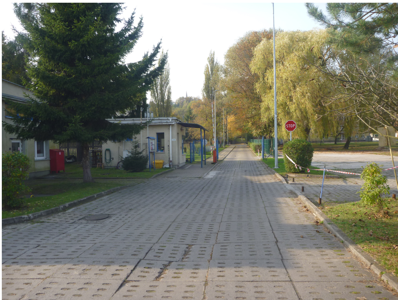
Droga wjazdowa na Bazę wraz z portiernią
