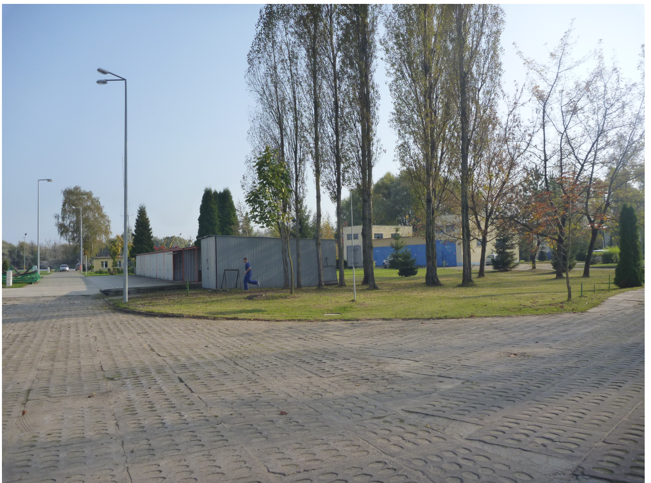
Budynek Wydziału Energetycznego, garaże blaszane oraz budynek garażowo-magazynowy
