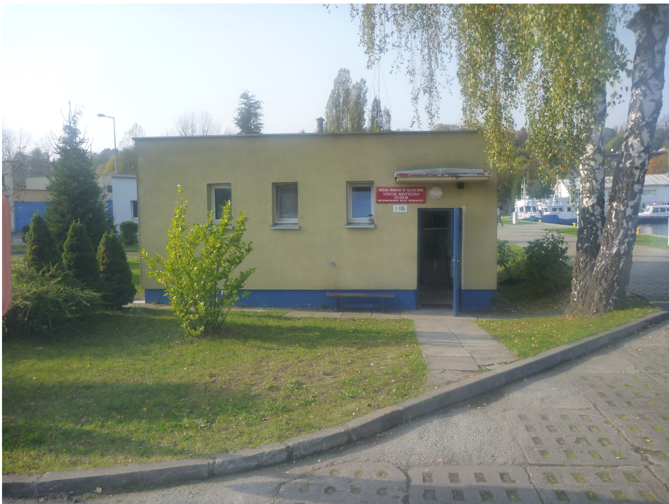
Budynek stacji nautycznej
