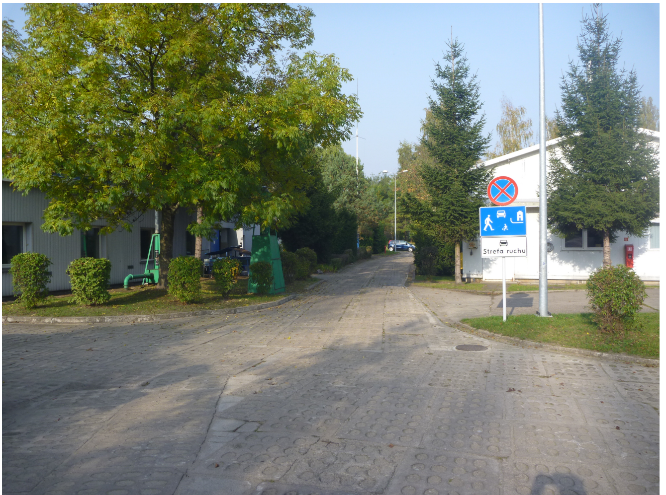
Budynek Oddziału transportu samochodowego oraz budynek byłego taboru pływającego
