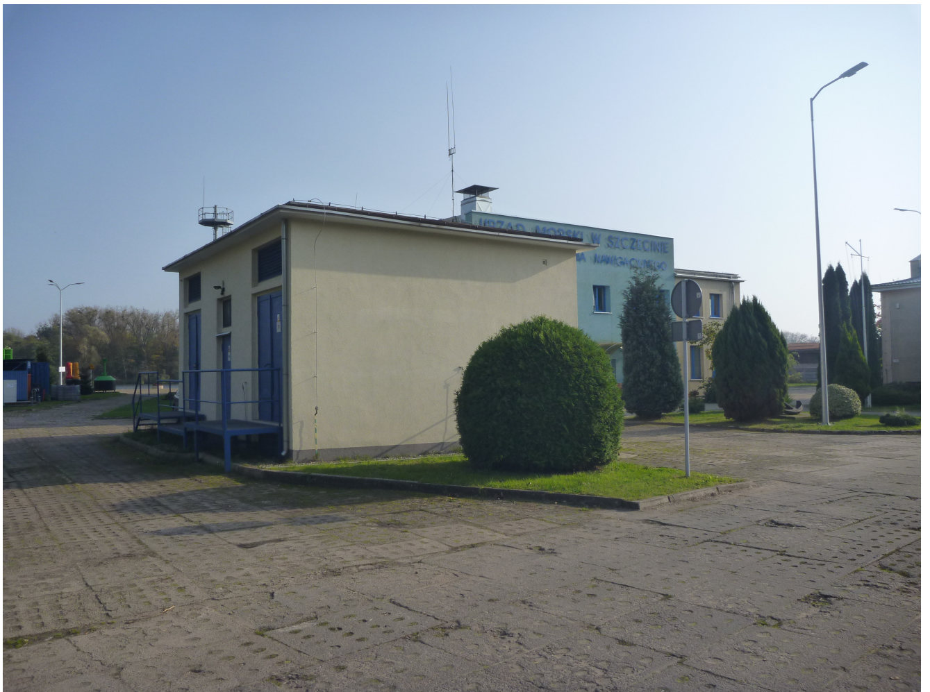
Trafostcja GUM SN092
