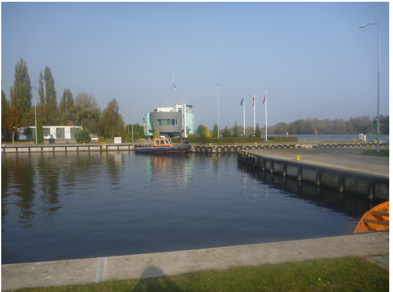
Basen północny – widok na wejście do basenu. W tle budynek garażowy Urzędu oraz Stacja Pilotów
