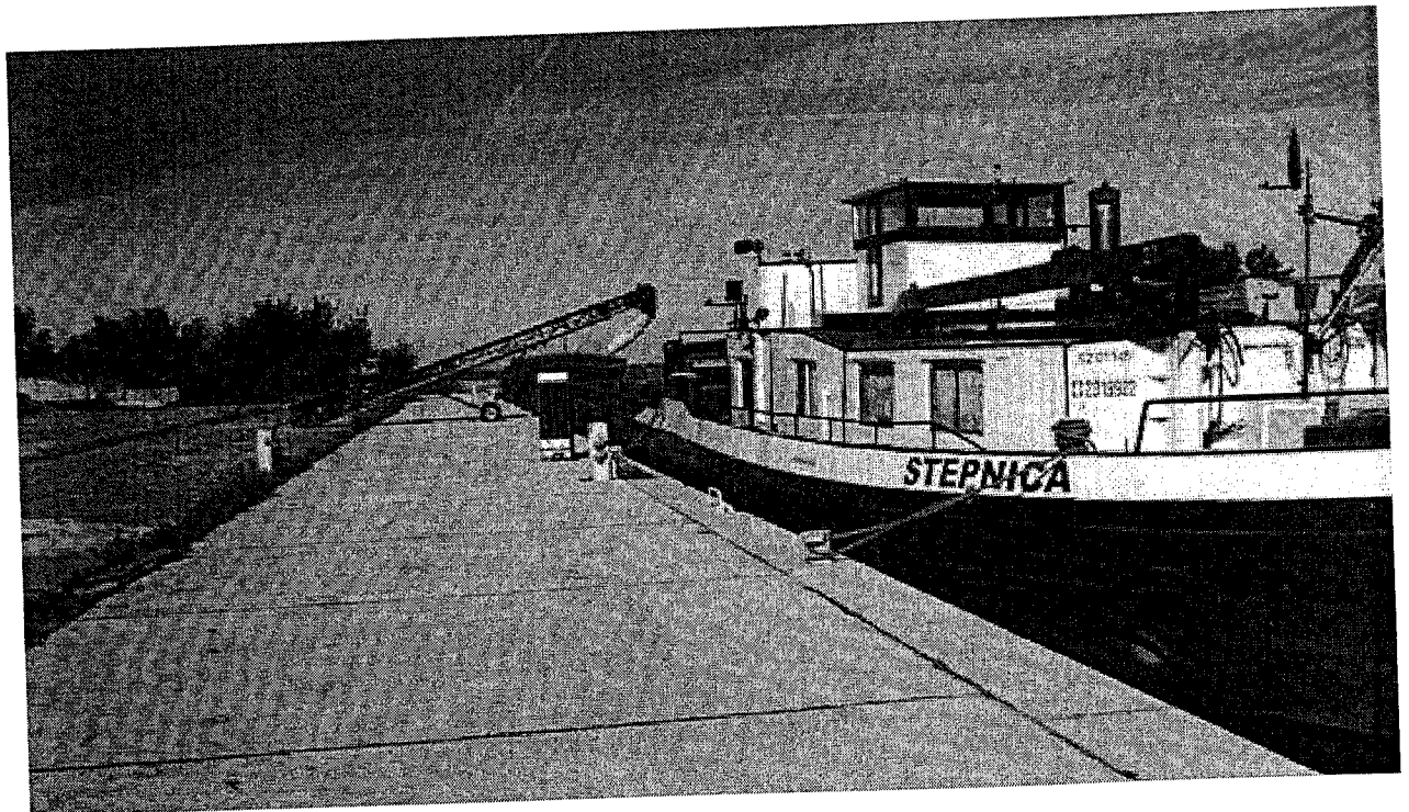
Fot.6. Widok na Nabrzeże Południowe.
