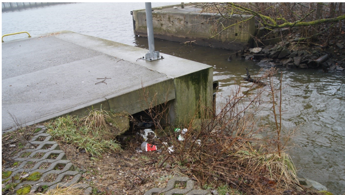
Fotografia powyżej : Widok na uszkodzone zakończenie Nabrzeża Parkowego na styku z ciekim wodnym wpływającym od wschodu do Kanału (rzeka Wieprza)
