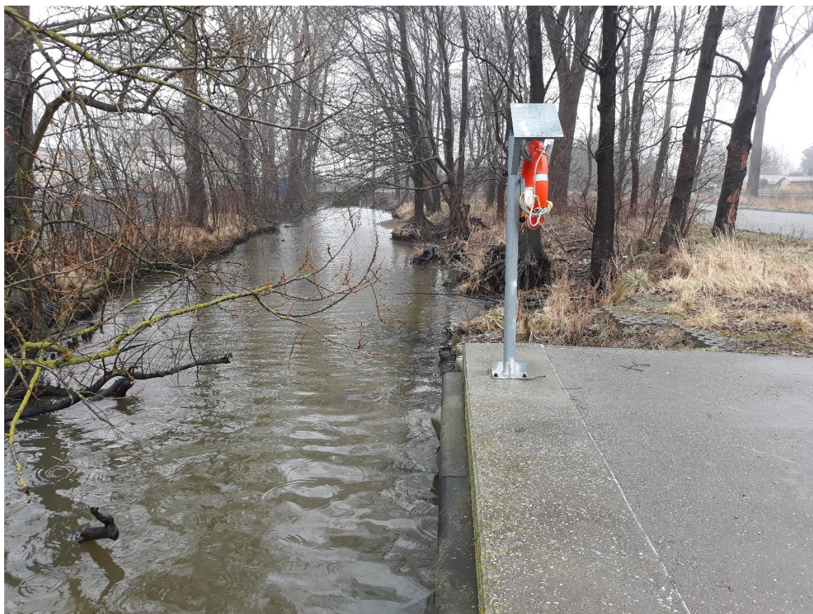
Fotografia powyżej i poniżej : Widok na oczep żelbetowy na przedłużeniu którego należy od nowa ułożyć umocnienie z geokontenerów (część 1)
