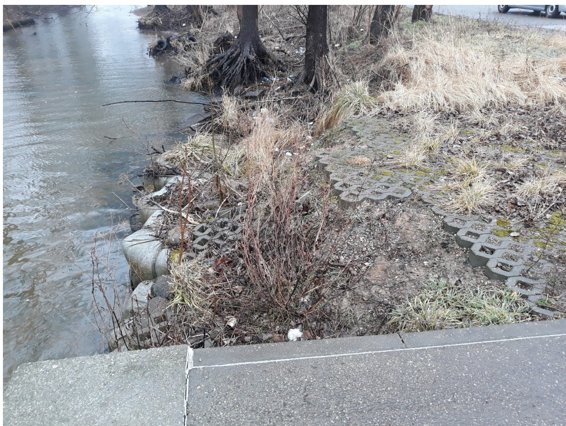
Fotografia powyżej i poniżej : Widok na oczep żelbetowy na przedłużeniu którego należy od nowa ułożyć umocnienie z geokontenerów (część 1)
